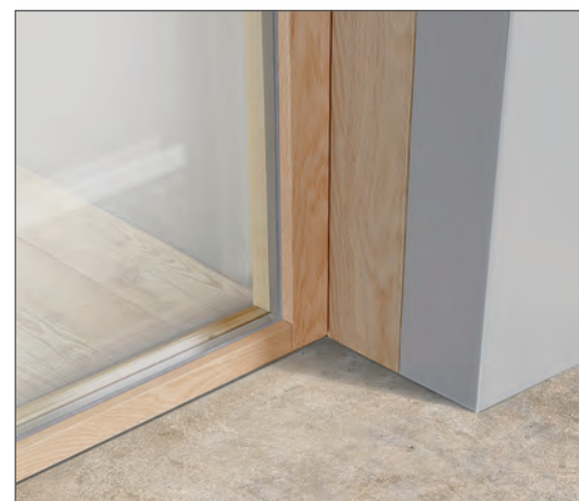
3 Telaio in legno incassato nel muro . Wooden frame embedded in the wall .
